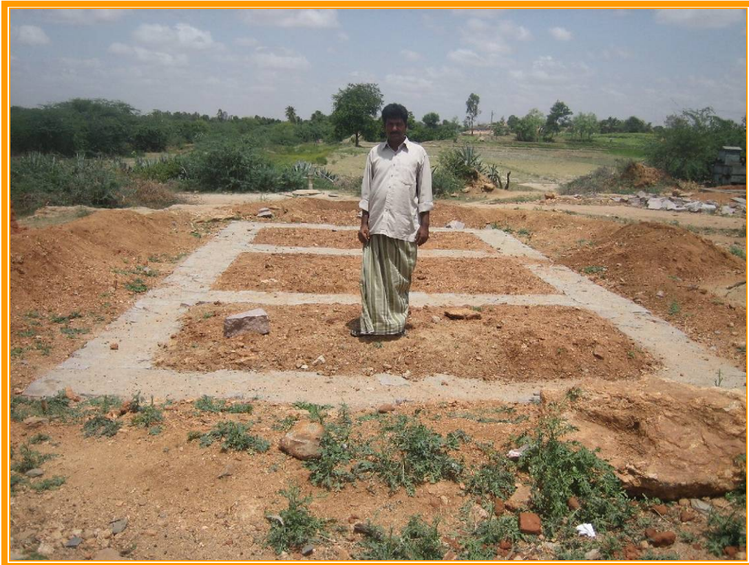
Vista de la primera fase de la construcción de viviendas, primera capa de hormigón. ©FVF 2006
