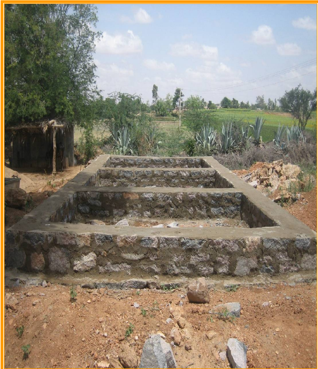
Muestra de los fundamentos de la construcción de la colonia de la aldea de D.Thanda. ©FVF 2006
